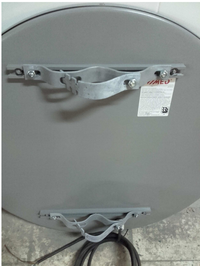
Fot. 2. Uchwyt uniwersalny zamocowany na profilu
